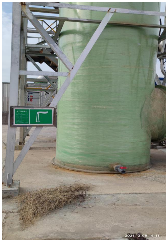
污水处理厂废气排气筒排污标志牌
