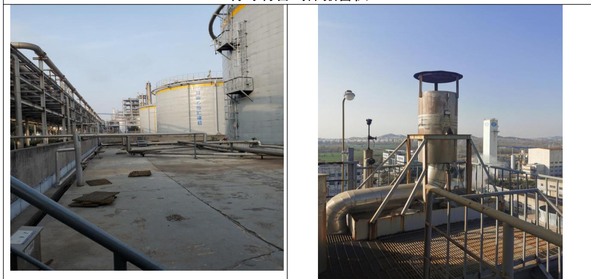
罐区围堰、导流沟
