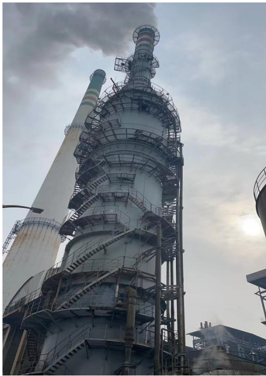
西厂区锅炉排气筒全景图
