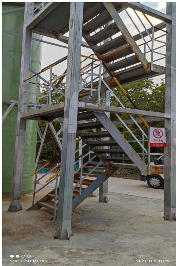
污水处理厂废气排气筒采样爬梯
