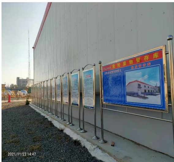
危废暂存间全景图
