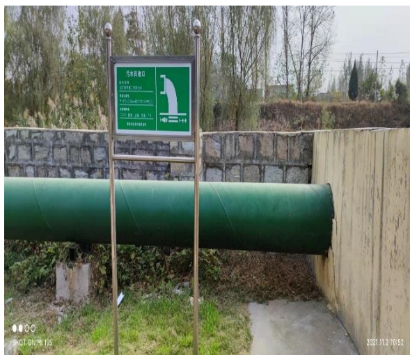
鲁化污水处理厂排污口标识牌
