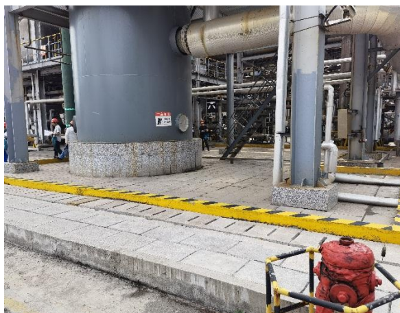
醋酸乙酯装置导流沟
