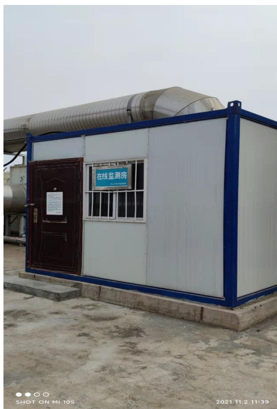
污水处理厂废气排气筒在线监测房
