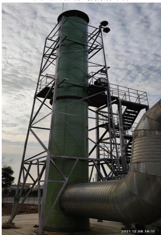
污水处理厂废气排气筒全景照
