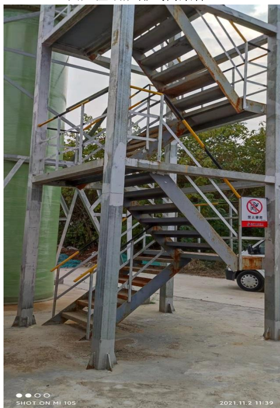
污水处理厂废气排气筒采样爬梯
