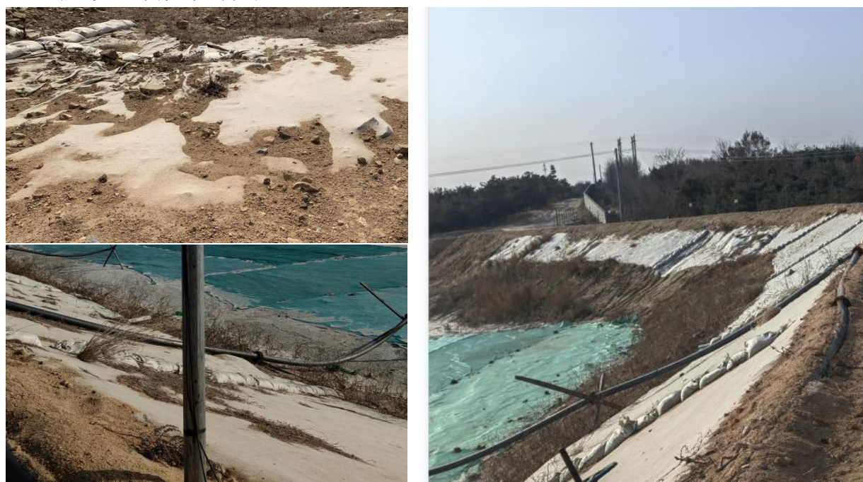
图 11.5-1 尾矿库边坡防渗
