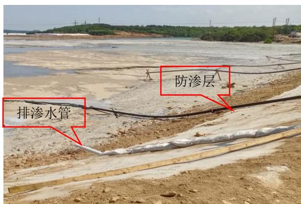
尾矿坝防渗、排渗情况
