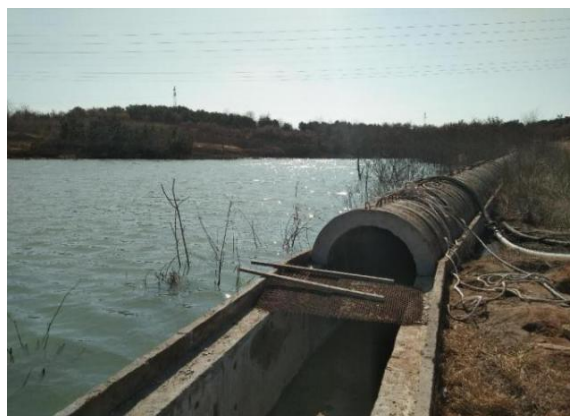
排水涵管~排水斜槽
