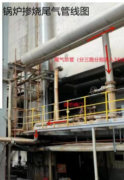
图 4.2-5 废气管线与治理设施衔接图
