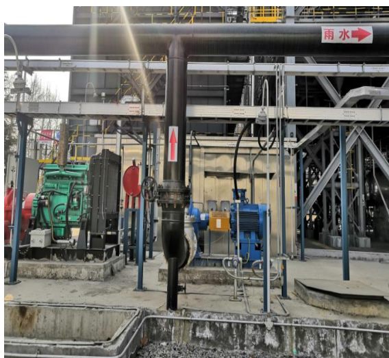
图4.2-8 醋酐装置初期雨水池
