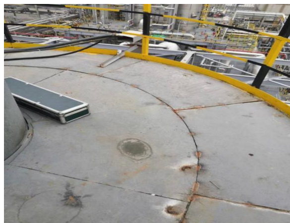
图4.1-4 裂解炉（反应炉）排气筒采样平台
