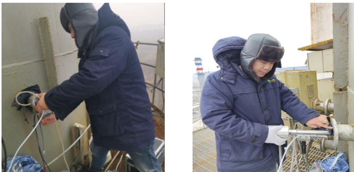
图 7.2-5 1-3#锅炉排气筒现场监测照片
