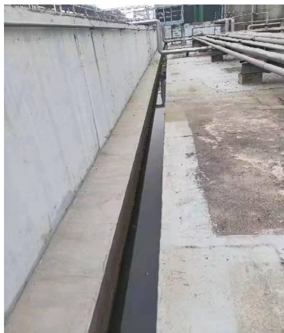
图4.2-10 罐区导流渠及围堰
