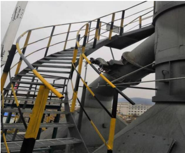
图4.1-1 裂解炉（反应炉）排气筒采样爬梯
