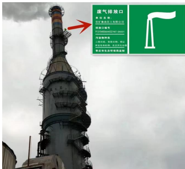
图4.1-6 西厂区1-3#锅炉排气筒全景及环保标识
