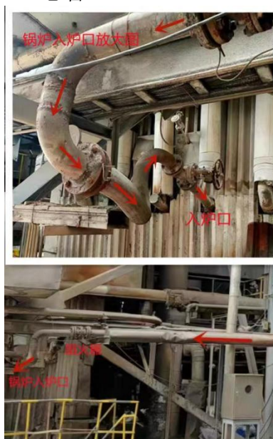
图 4.2-5 废气管线与治理设施衔接图
