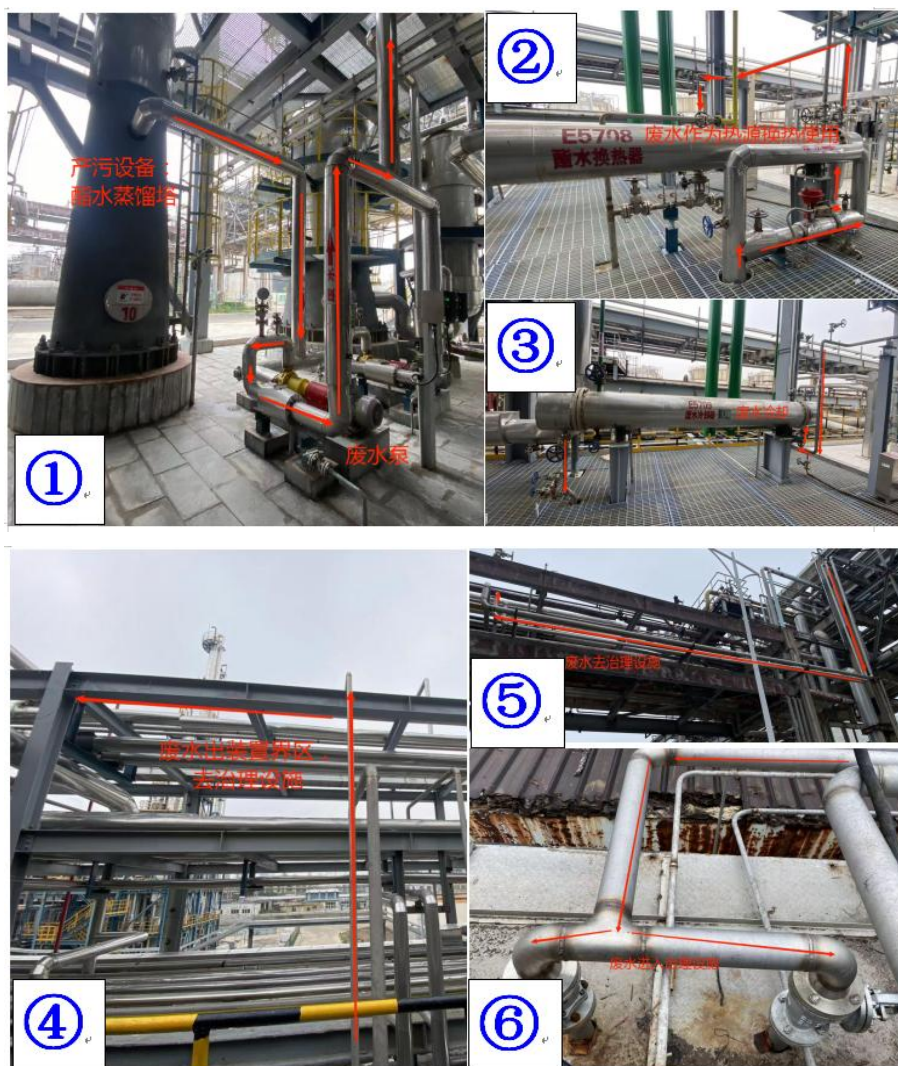
图 4.2-6 废水排污管线图
