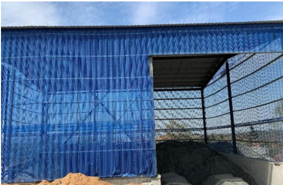
尾砂堆场围挡
