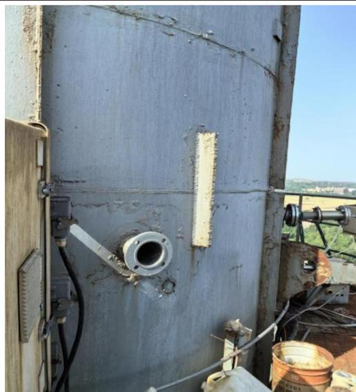
图 3.1-8 DA001 排气筒监测孔
