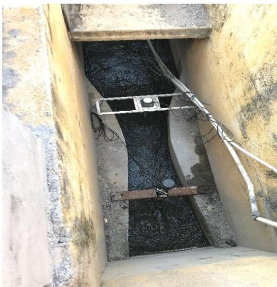
图3.1-3 鲁南化工污水处理厂明渠流量计
