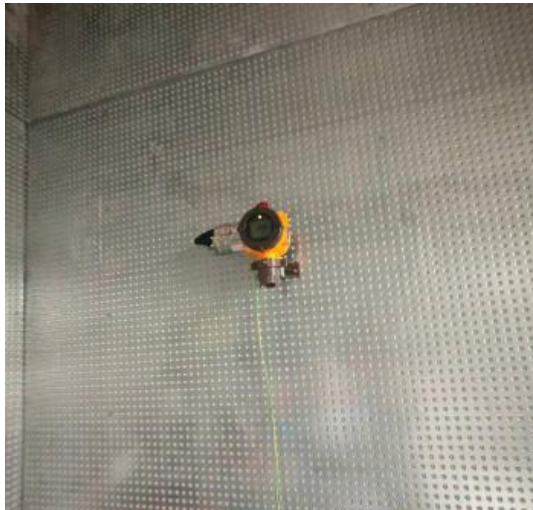
图 3-12 气瓶间氧气浓度检测探头
